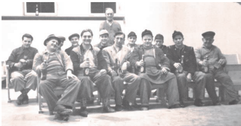
1954: Pause bei den Bauarbeiten der neuen Kirche in der Ulrichstraße 3
