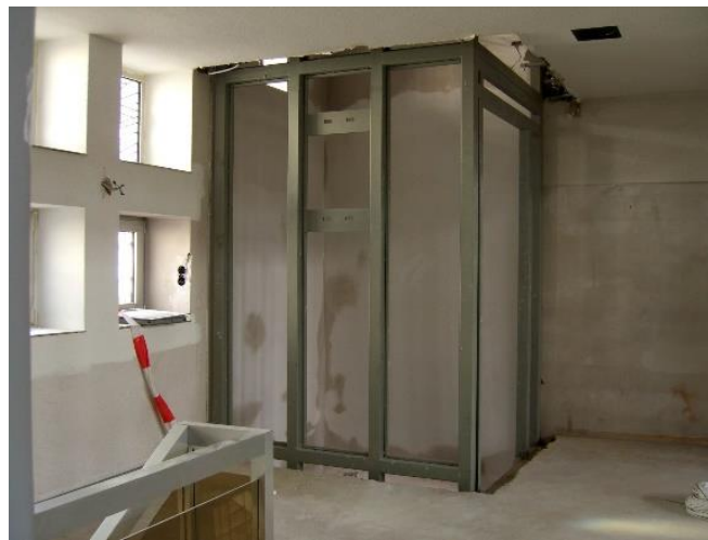
Einbau eines modernen Aufzugs zur barrierefreien Erschließung des Kirchenschiffs
