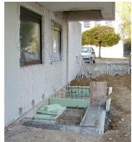
Einbau eines modernen Aufzugs zur barrierefreien Erschließung des Kirchenschiffs
