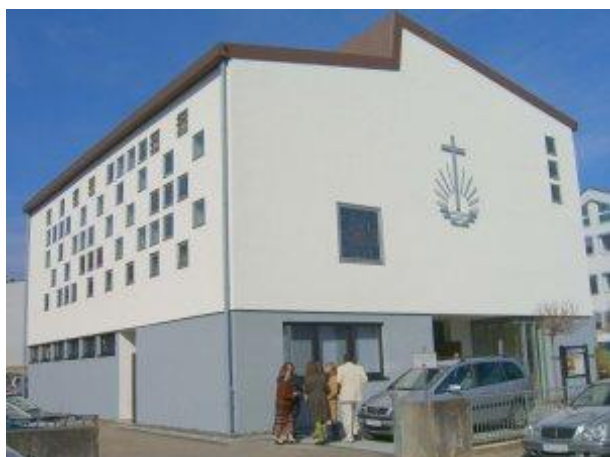
Neue Farbgestaltung der Fassade
