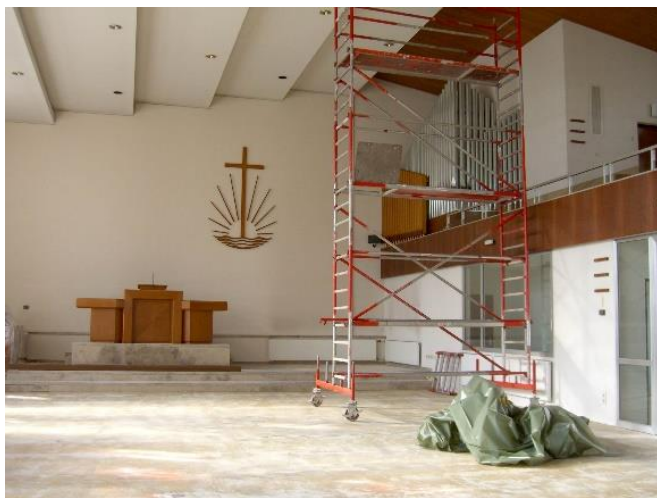
Umbaumaßnahmen im Kirchenschiff
